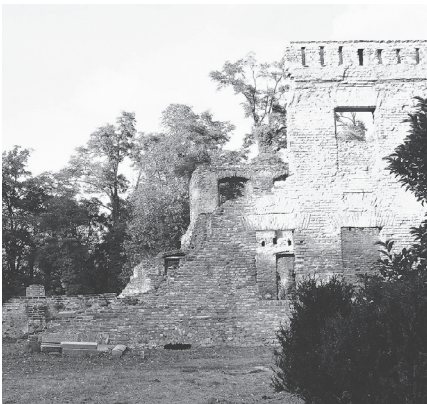
Detail der freigelegten Schlossruine. Die Aufnahme wurde 2011 vom gleichen Standpunkt aus gemacht. Wie das Foto von 1986.
