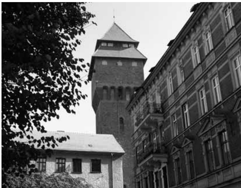
Der Wasserturm zu Kreuzburg Wieża ciśnien w Kluczborku Foto/Zdjęcie: Emil Feilert
