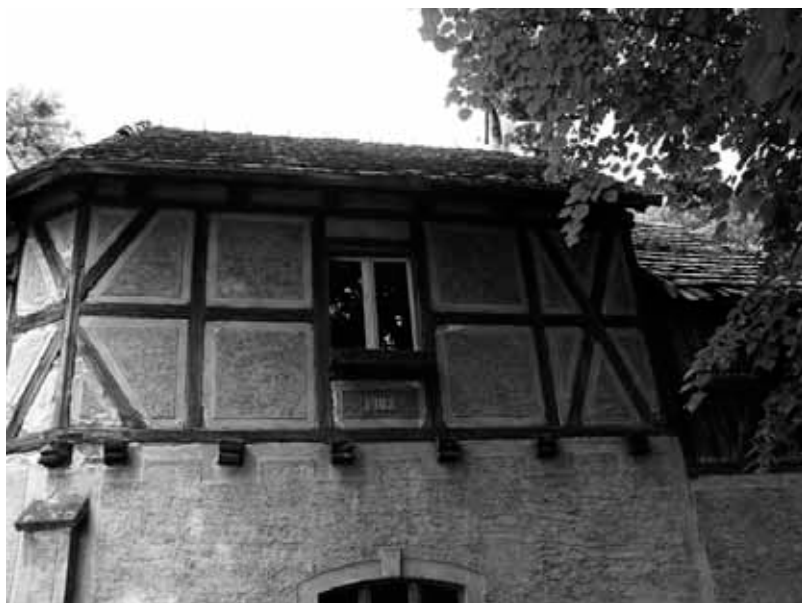
Budynek w Wędryni / Gebäude in Wendrin
