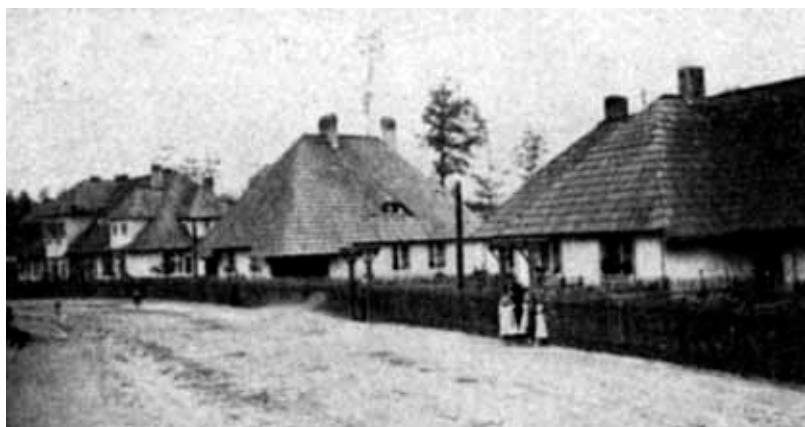
Domy dla górników. w Giszowcu/Gieschewald Bergarbeiterhäuser Quelle/Źródło: V. Bethusy-Huc, Mein Oberschlesien , Kattowitz 1912, S. 177.
