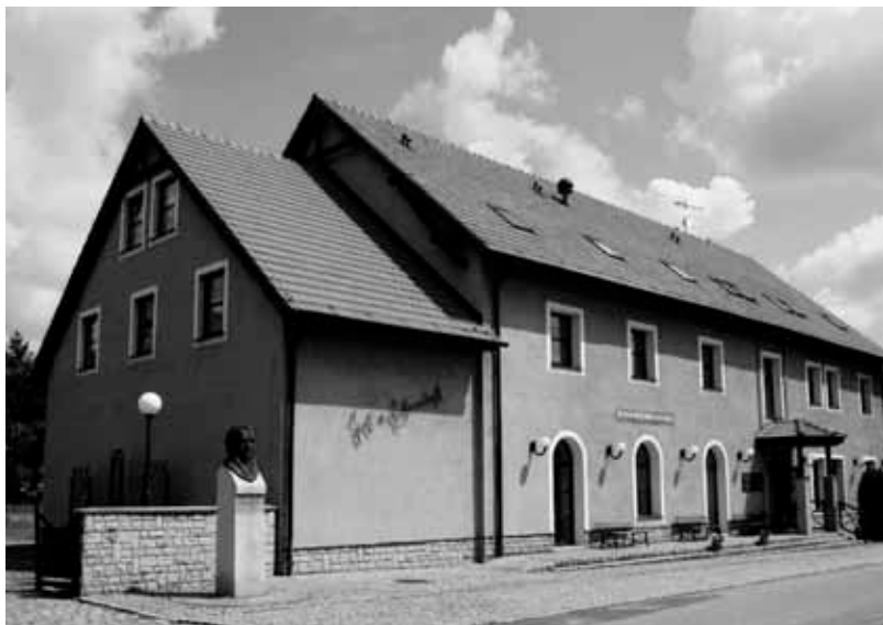
Budynek Centrum Kultury i Spotkań im Eichendorffa w Łubowicach Das Joseph von Eichendorff- Oberschlesische Kultur- und Begegnungs- zentrum in Lubowitz Zdjęcie/Foto: A.Walko
